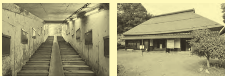
北御牧小学校前地下通路
